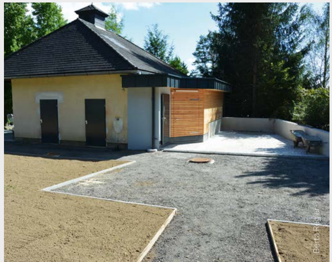
Zubau und Müllplatz sind fertig, die Fassade fehlt noch
